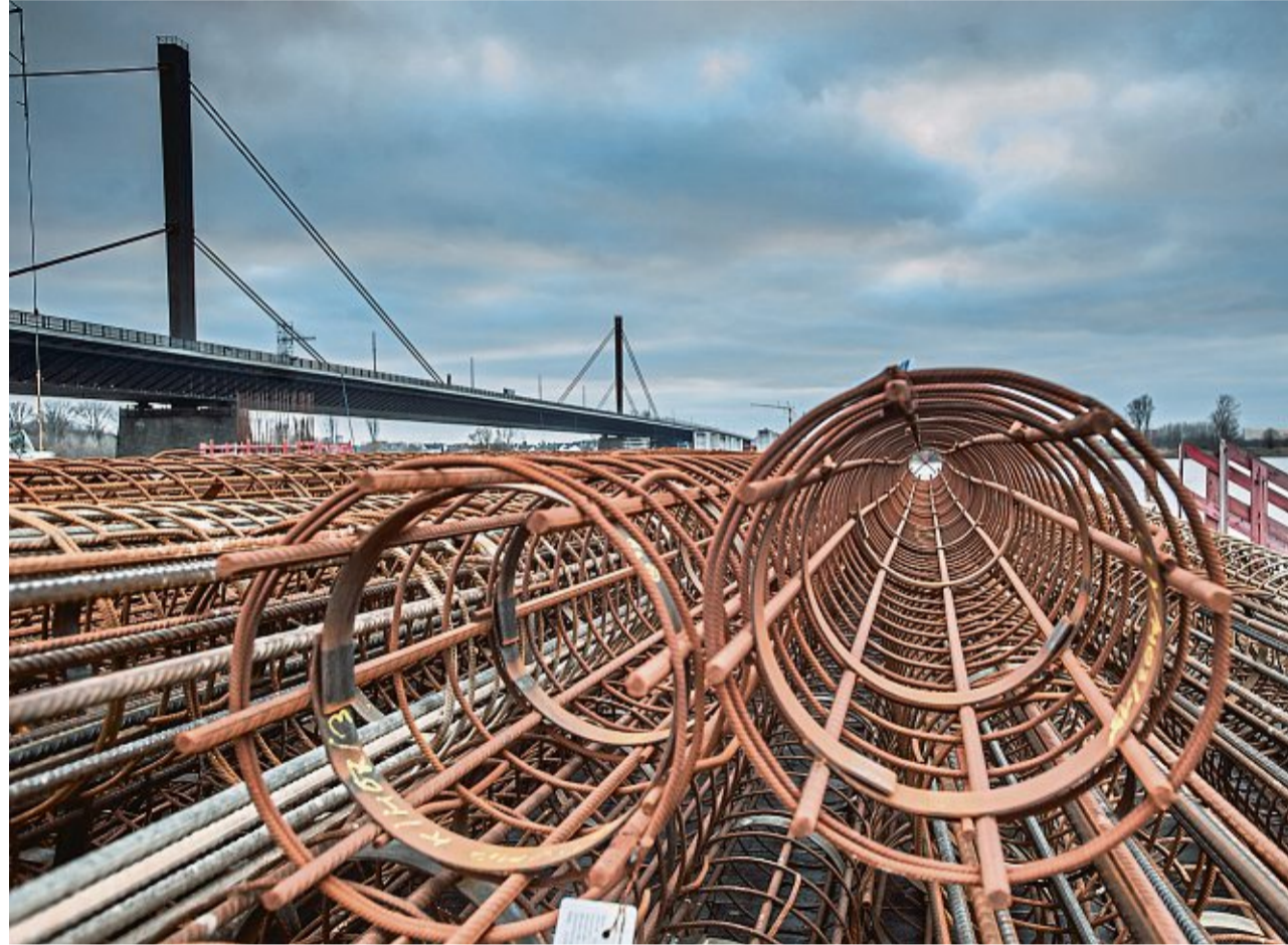
Die Stahlgerippe für die Pfeiler der neuen Brücke lagern am Rheinufer.
